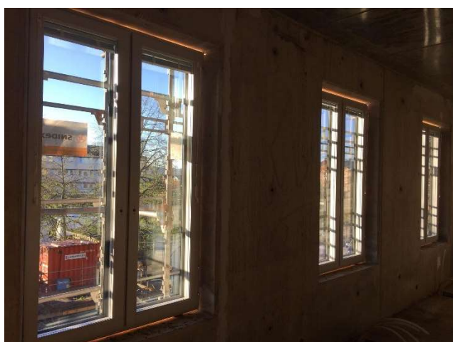
Monterade fönster sett inifrån.
