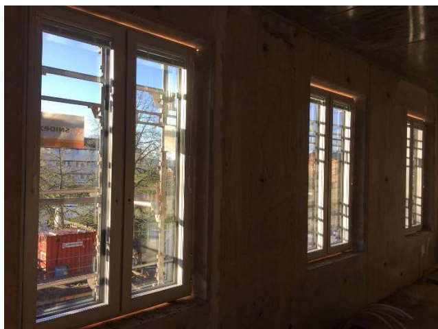
Monterade fönster sett inifrån.
