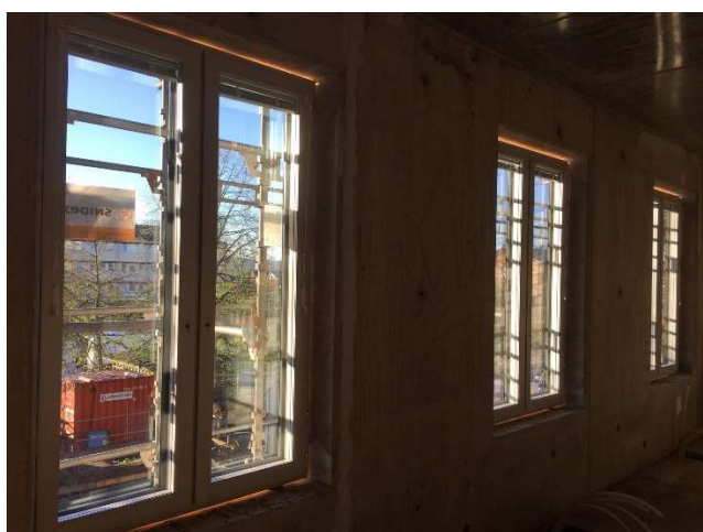
Monterade fönster sett inifrån.
