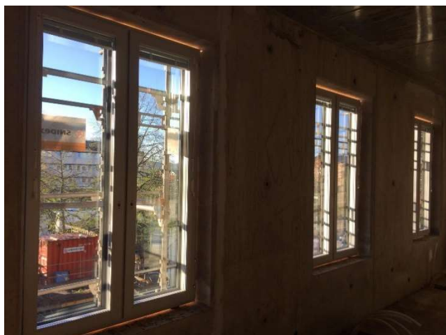
Monterade fönster sett inifrån.
