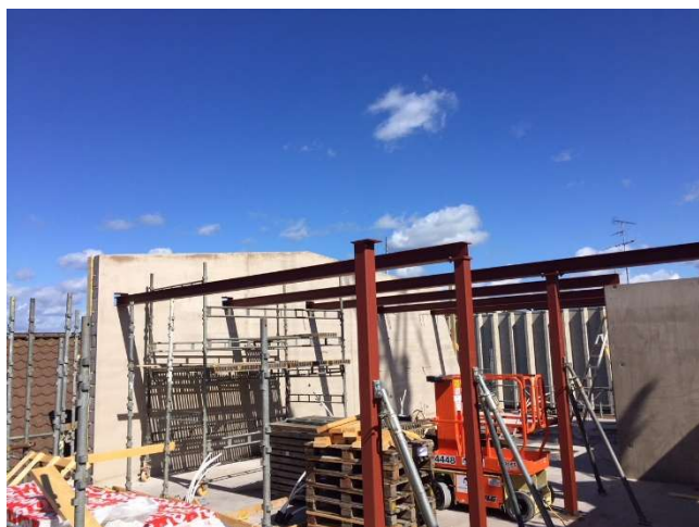
Stålbalk på betongväggarna ska bära upp takstolarna.
