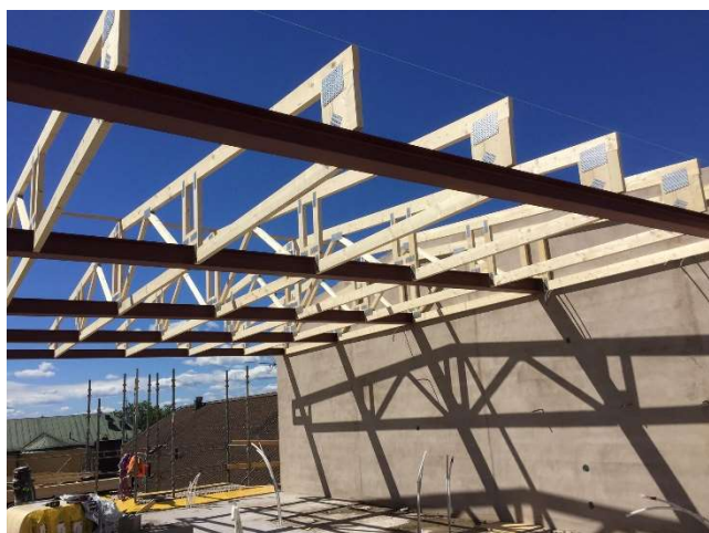
Takstolar på stålbalk.
