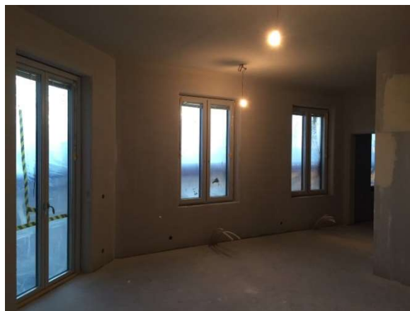
Lägenhet spacklad och delvis målad.
