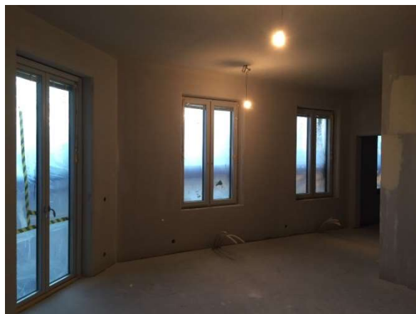
Lägenhet spacklad och delvis målad.
