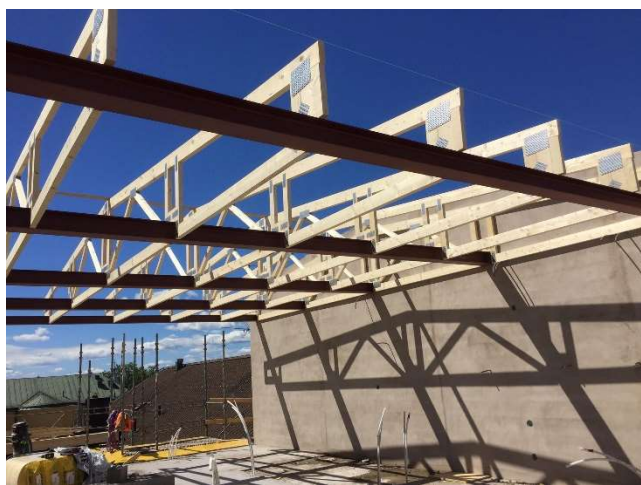
Takstolar på stålbalk.
