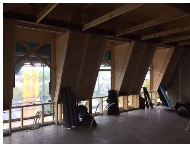
Takkupor redo för fönster.
