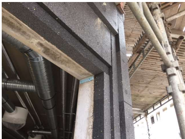
Hornpromier för fasaden.
