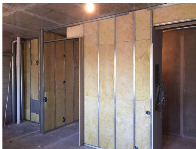
Innerväggar isolerade.
