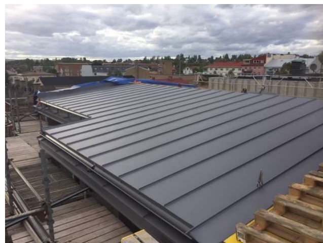
En del av taket klädd i plåt.
