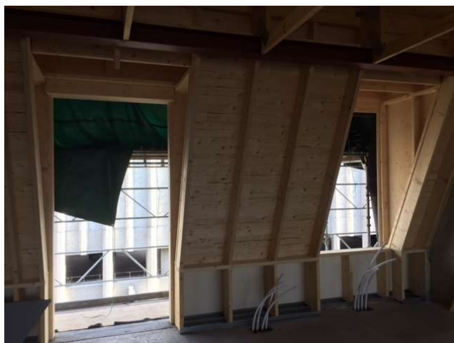
Takkupor mot Storgatan.
